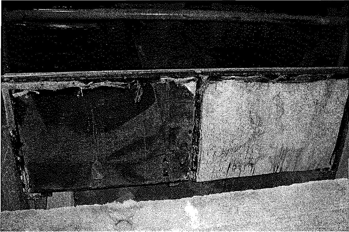
Фото.5. Образец №1 после испытания. Обследование конструкции.
